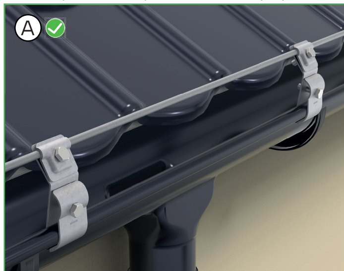
przewodzenie przewodu wzdłuż rynny
